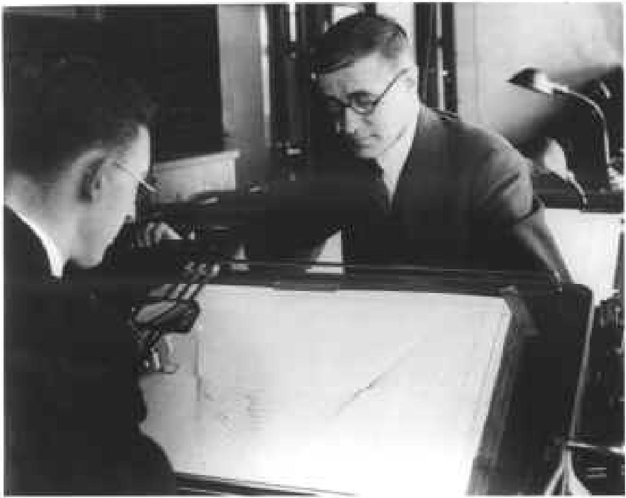
**Fig. Operatore (Samuel Caldwell) alla console dell'analizzatore differenziale, costituita da un'interfaccia di tipo grafico. L'operatore manipolava a mano un puntatore per seguire le curve sulla carta, che venivano poi integrate (o elaborate in altro modo) dalla macchina fino a diventare un grafico in uscita. Vannevar Bush osserva la console.**
