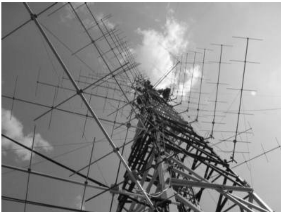
Il sistema di antenne VHF del Radio Club di Budapest (Ungheria)
