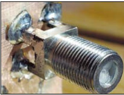
Connettore F: notare le saldature anche sul lato connettore
