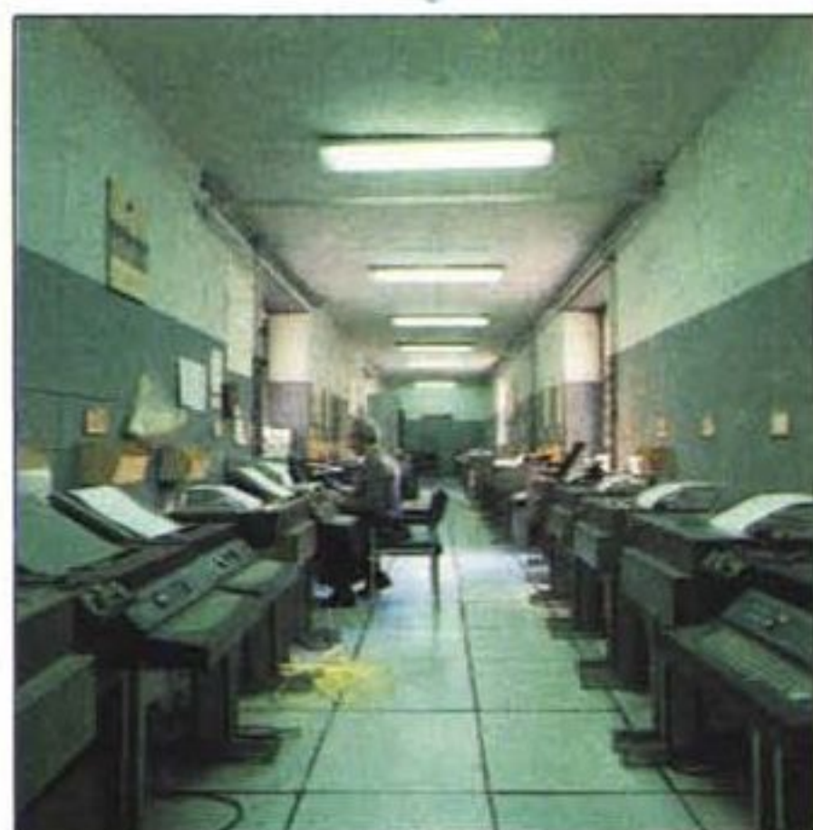
Tre ambienti operativi del C.N.M.C.A.. A sinistra la sala telescriventi, dove si è collegati in bassa velocità con tutti i servizi meteorologici nazionali. Al centro la sala facsimili, dove si ricevono via fax le carte meteorologiche di tutto il mondo. A destra la sala operativa vera e propria, dove si raccolgono le informazioni e si studiano le situazioni.
