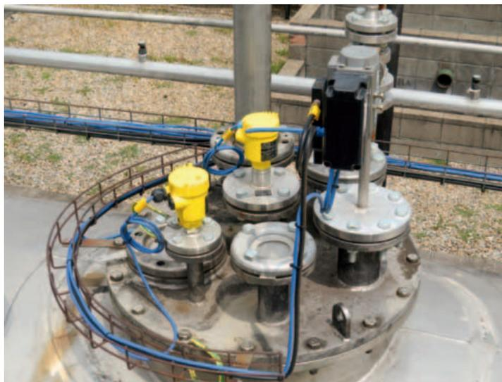
*Lo stretto raggio radar del VegaPuls 64 ne consente il montaggio anche in presenza di elementi metallici*
