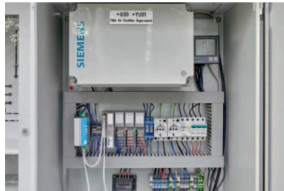
Figura 7 - Nel quadro elettrico, nel punto di connessione alla rete, è installato anche un controllore AXC 1050 (al centro) che funge da regolatore di immissione in rete
