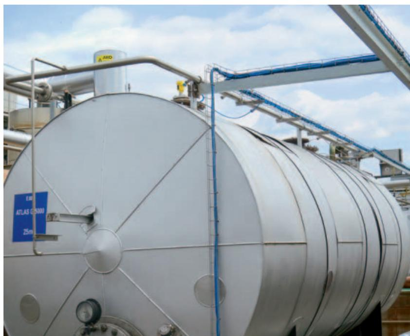
*Uno dei serbatoi di stoccaggio delle materie prime: il VegaPuls 64 consente una misura di livello senza contatto fino al fondo del serbatoio, nonostante le diverse installazioni interne*
