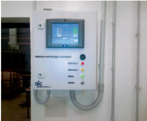
**Armadietto, concentratore grafico e concentratore numerico: tre pezzi di un unico sistema di monitoraggio di un deposito di materiale radioattivo. Gli armadietti sono collegati ai sensori, e trasmettono i dati al server che li mostra su due display: uno grafico e uno numerico**
