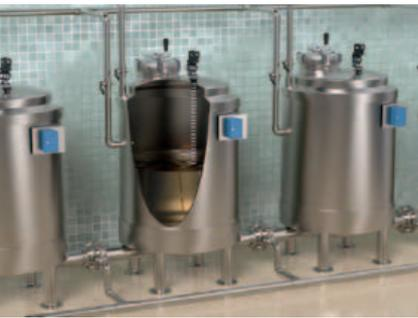
*Sensori a ultrasuoni K50U e nodi wireless Q45U associati a un controller wireless DXM100 è la soluzione pensata per il controllo preciso di serbatoi*
