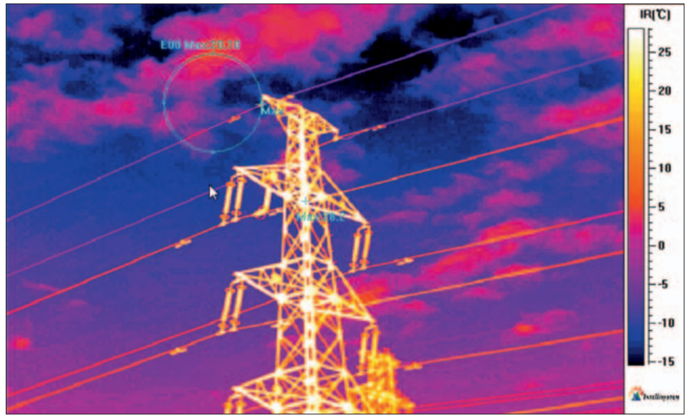
Un esempio di analisi attraverso le immagini termiche
