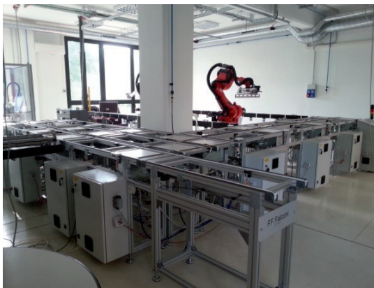
Figura 1 - L’impianto pilota di de-manufacturing
