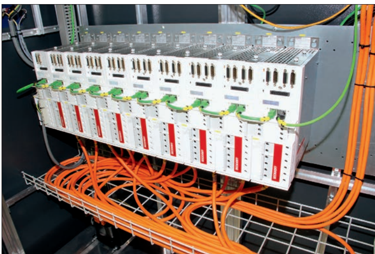
Figura 3 - Gli azionamenti della serie AX5000 utilizzati da Durrer
