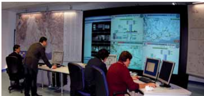
La sala controllo della rete idrica di Reggio Calabria
