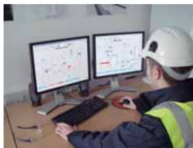
PlantWeb di Emerson è una soluzione per il controllo e l'efficienza globale dell'impianto
