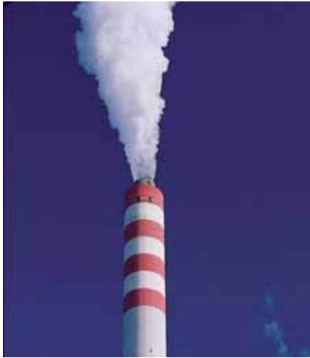
Il controllo delle emissioni in atmosfera aumenta la conformità alle normative
